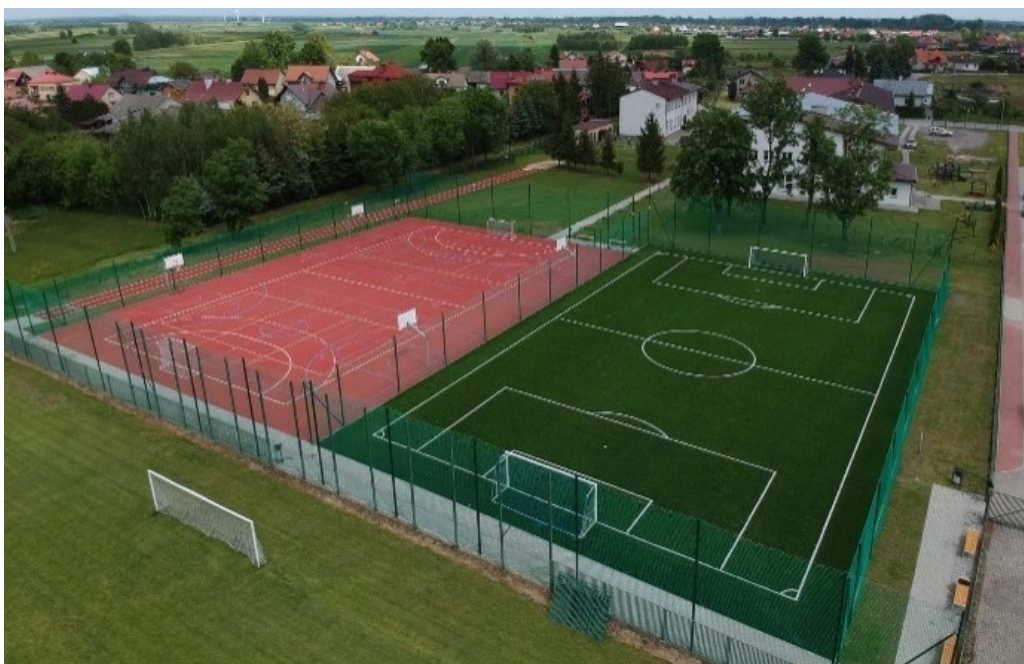
Zdjęcie 3 Gotowe obiekty sportowo –rekreacyjnych w Woli Mieleckiej
