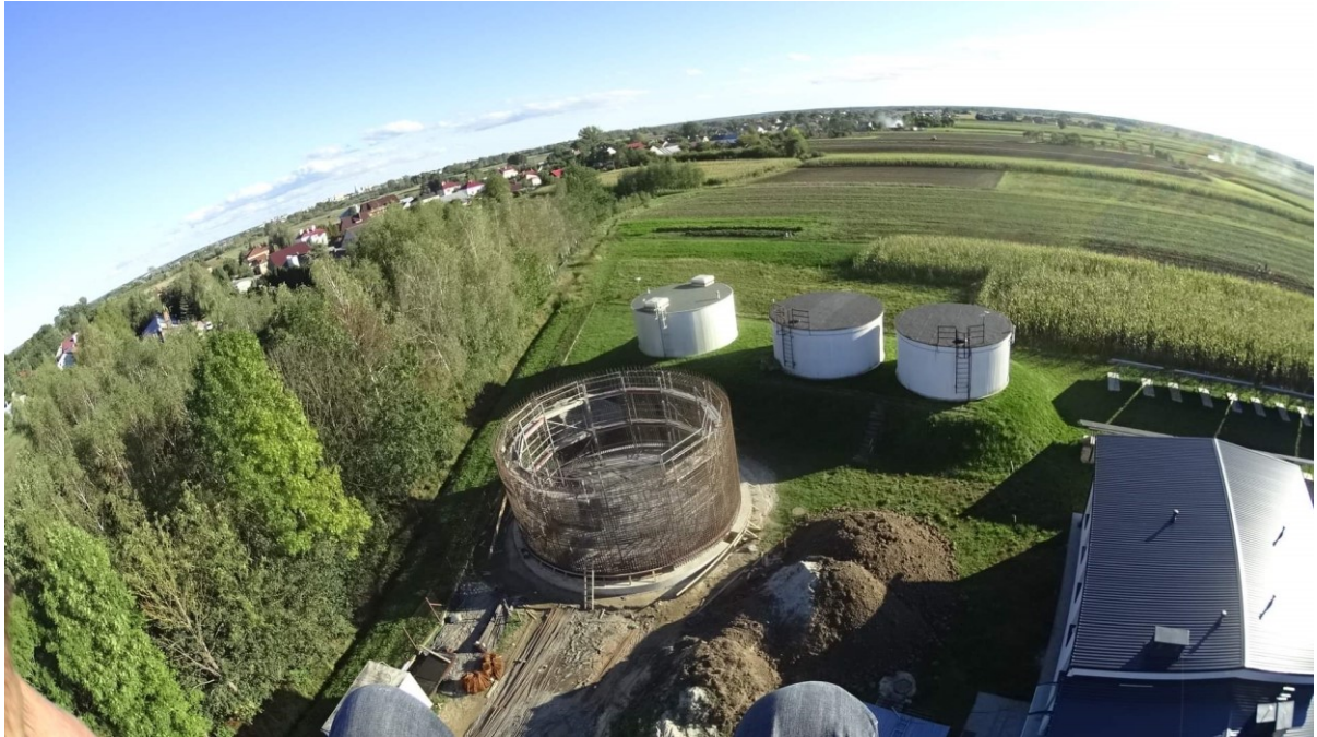
Zdjęcie 3 Budowa zbiornika wody czystej w Rzędzianowicach
