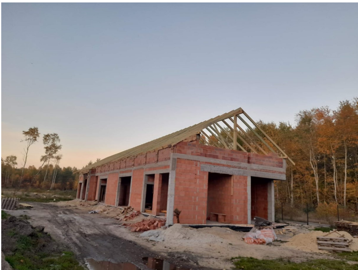
Zdjęcie 4 Budynek GZGK w trakcie budowy
